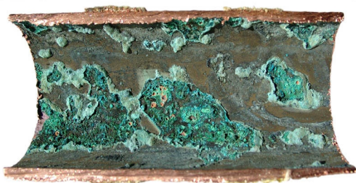
Rohr ohne Schutzschicht
